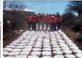
土のうの締め作業中
