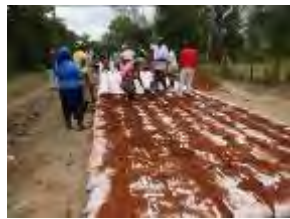
土のう技術訓練
