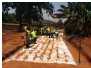
土のう技術訓練実施風景
