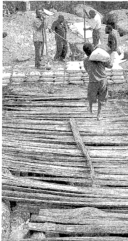
土嚢を並べて地盤を補強するモゲ族の男性たち。手前が老朽化した丸太橋
