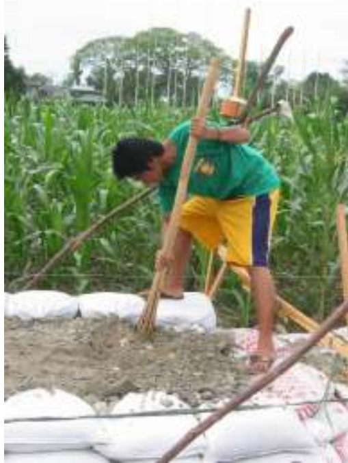
締固めに対する独自に 工夫した道具
