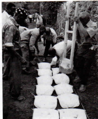
土を入れた土のう袋をオリジナル木枠で整形、泥や土を除去した道に敷設していく。
