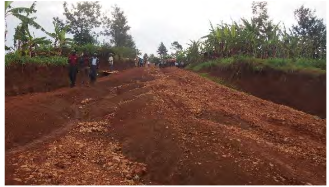
写真 10 雨水によりえぐり取られた道路
