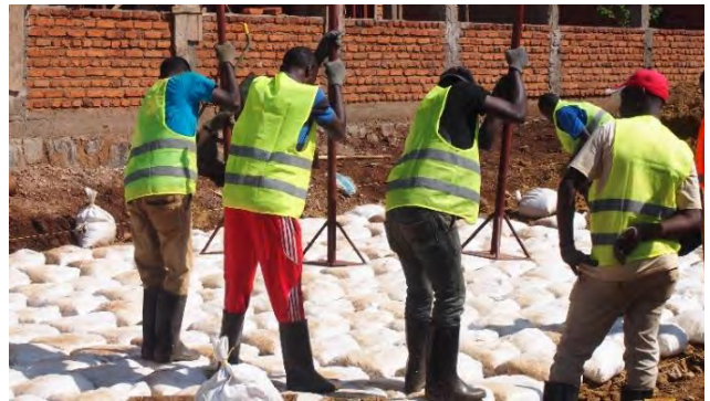
土のうのコンパクション作業
