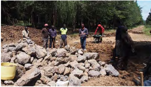
写真3 排水路作製班
