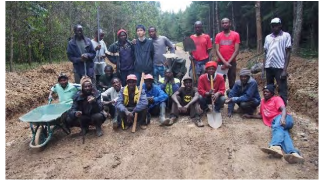
施工記念写真
