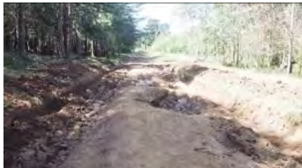
写真 2 施工前の状態
