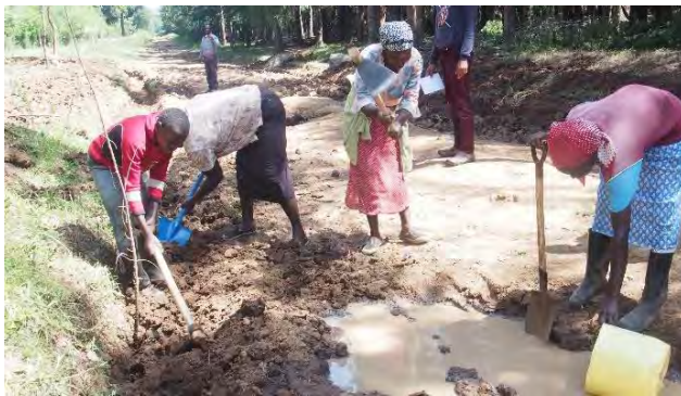
水たまりの除去作業
