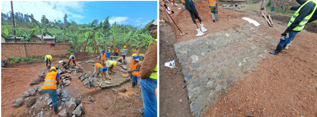
雨水を逃がすための溝を作る
