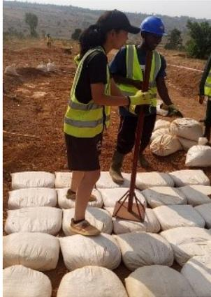
← 土のう袋を敷き詰め、コンパクターで締め固める
