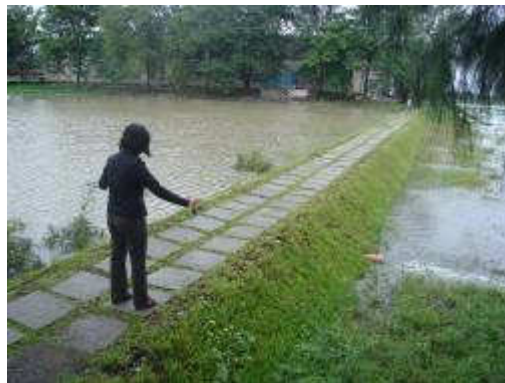
写真1 雨季でも通行性が確保できるようかさ上げされた歩道
