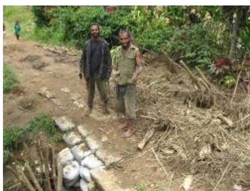
写真2 「土のう」を横断排水溝の埋戻し に利用した住民
