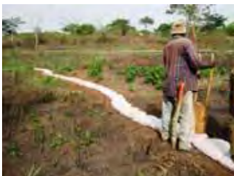
土壌流出防止策として積まれた土のう(カメルーン)
