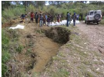
道路委員会メンバーによる擁壁施工の様子
