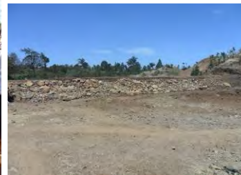
写真 2 1.7 m の堤防が新たに築かれたアースダム
