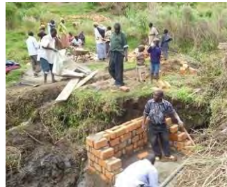
水源の湧水取水口付近に設置される、簡易タンクの建設
