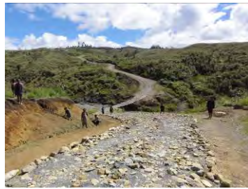
施工後の様子
