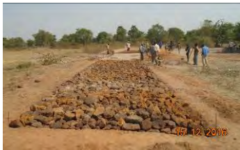
ファラバ村、栗石+コンクリートによる水没箇所の路面補強（沈下橋）
