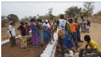
ウラテンガ村での土のうを利用した盛土工施工の様子
