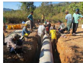
カルバート設置
