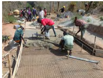
コンクリート舗装の様子
