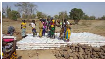
ウラテンガ村での土のうを利用した盛土工施工の様子
