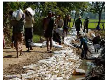
土のうによる、盛土工法面保護
