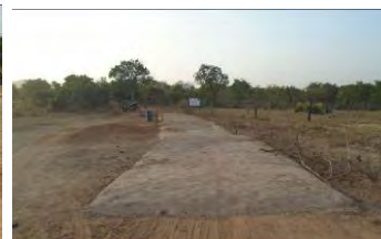
ファラバ村、栗石+コンクリートによる水没箇所の路面補強（沈下橋）
