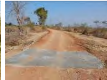
施工後の道路
