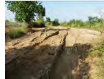
施工前の道路
