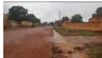
整備後の雨季の様子
