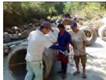
パイプ設置位置確認状況
