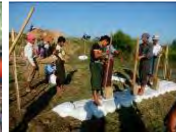
専門家による土のう工法研修
