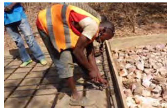
坂部コンクリート舗装での鉄筋組
