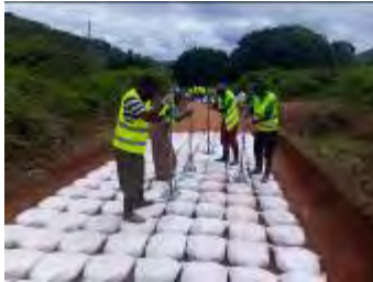
マクエニの現場での締固め作業
