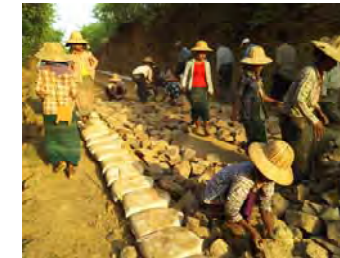
砕石敷き並べの様子
