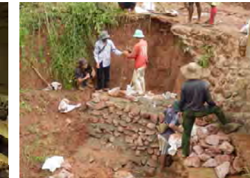
土のうと石積による斜面補強
