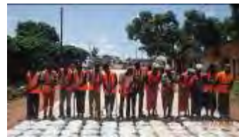
土のう締固めの様子
