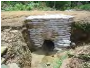
既設パイプ端部を土のうで補強
