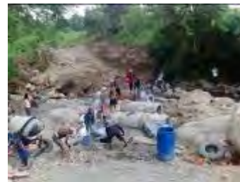
パイプ間中詰材バケツリレー
