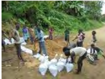
路面沈下部に土のうを敷設する様子
