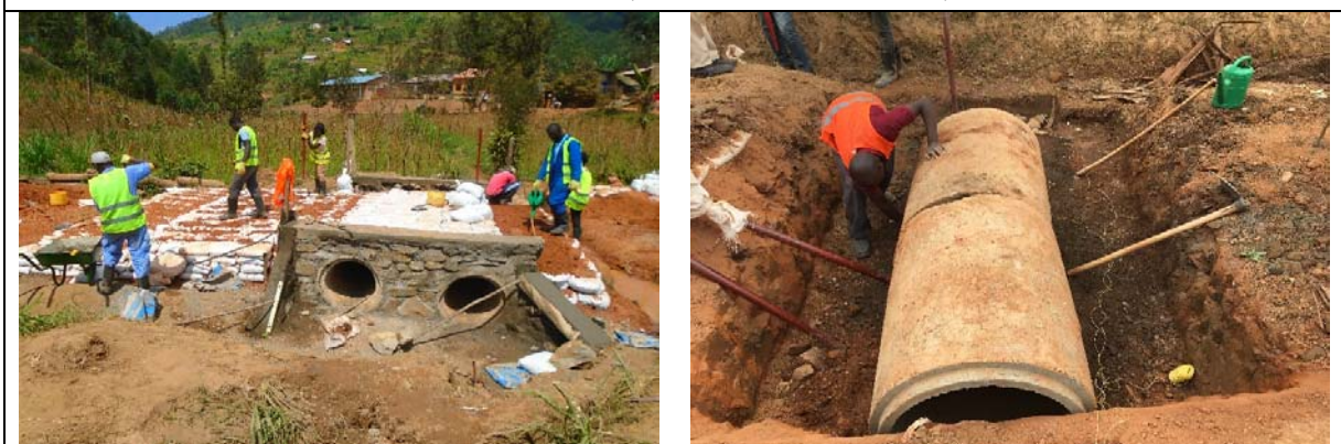
4. 排水管設置の様子（ガケンケ郡、ルリンド郡）
