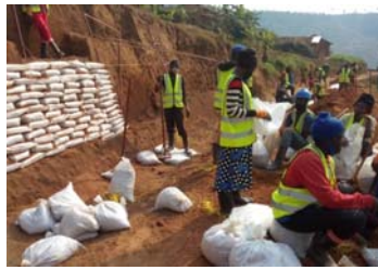
ンゴロレロ郡でのパイロット施工
