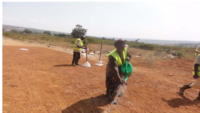
9 表層撤出土の含水比調整のための散水状況
