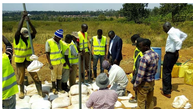
6 土のう締め作業
