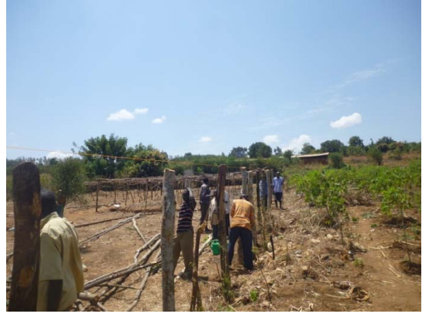
フェンス設置状況
