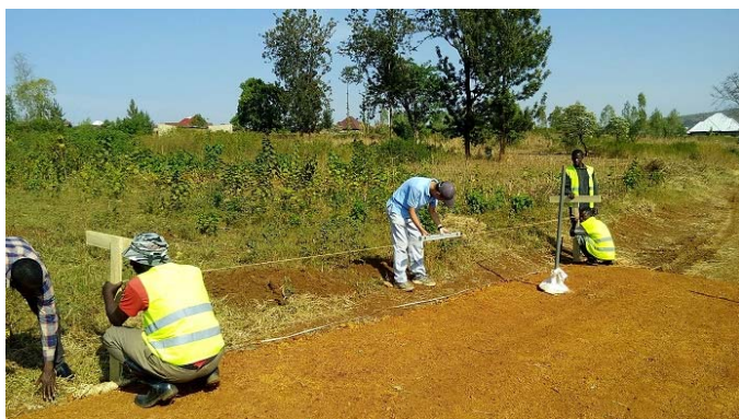
3 側溝勾配の確認状況
