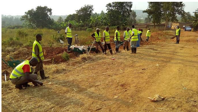
1 側溝設置個所の表示
