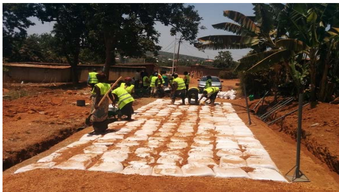
8 土のう間隙間の間詰め
