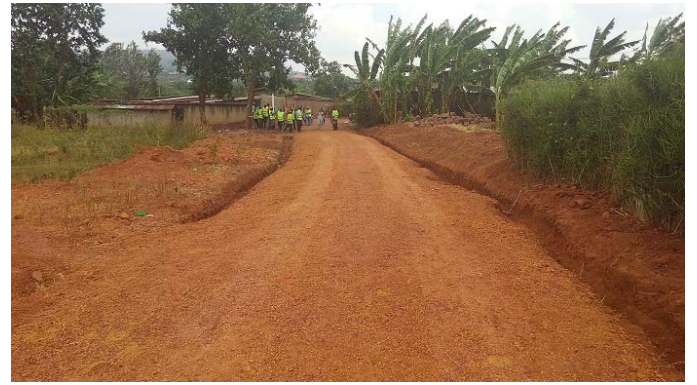
11 施工後の様子
