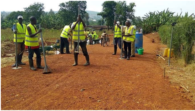
10 表層の締固め作業
