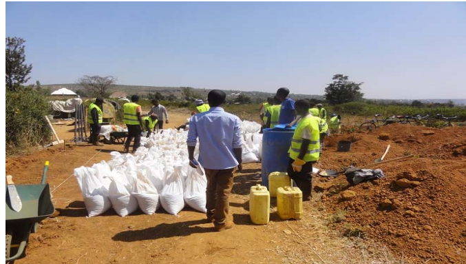
4 土のう中詰状況
