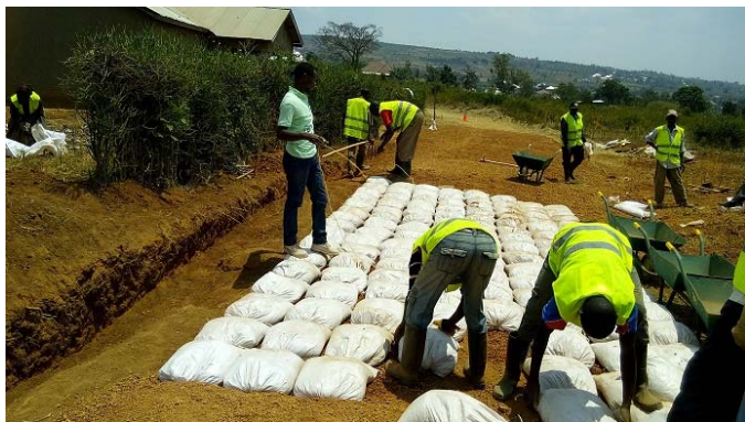
5 土のう敷設状況
