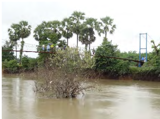
川の水面は乾季には吊り橋下10m以上あった樹木のごみで上昇水位がわかる
