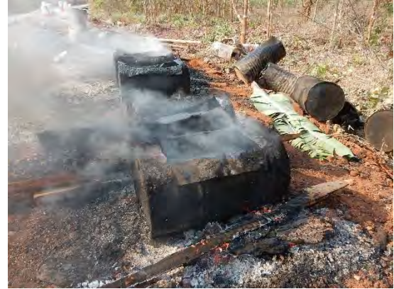
現場の近くでアスファルトを溶解 アスファルトはタールともいう ( asphalt tar )
