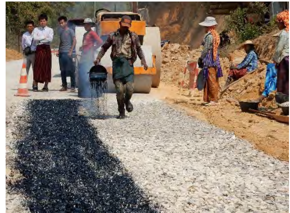
現場の近くでアスファルトを溶解 アスファルトはタールともいう ( asphalt tar )
