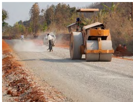
舗装の拡幅施工
