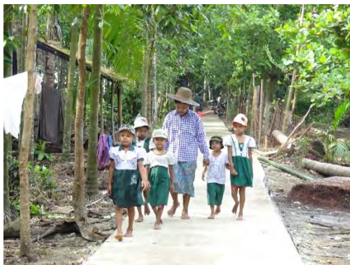
舗装が 完成した道路 雨の日でも安心して通学できる
