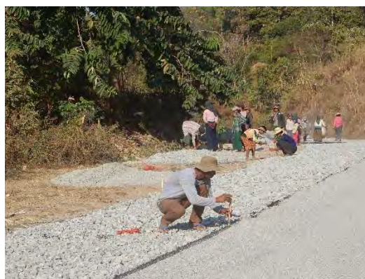
舗装の拡幅施工
