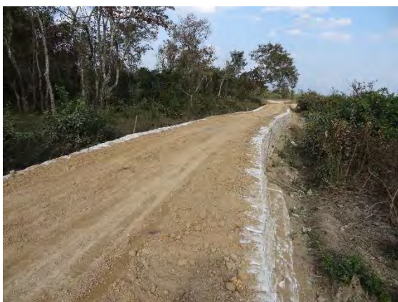
土のうを積んで嵩上げした道路
