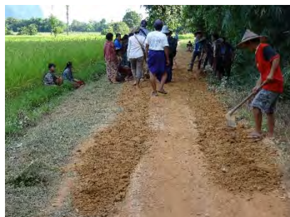
排水してわだち跡に土を 入れて補修
