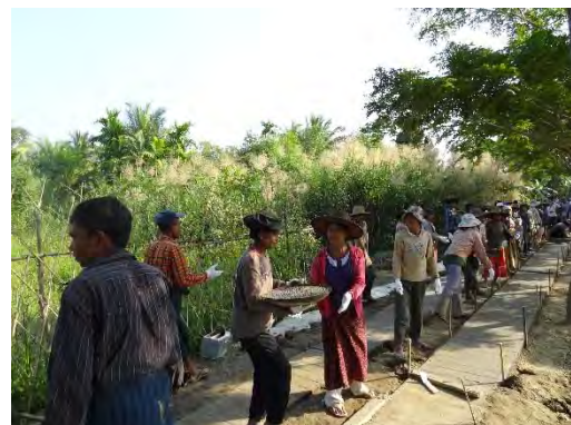
村人がコンクリートの運搬をバケツリレー している
