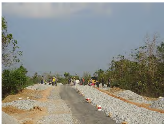
道路の半分ずつを舗装施工している
