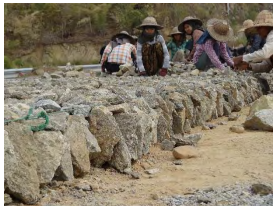
下部の1層目は 大きな碎石を 手作業で敷並べる
