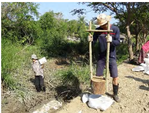
土を詰めた土のうを締め固めているところ 現地製作の締め固め用具のタコを使用している
