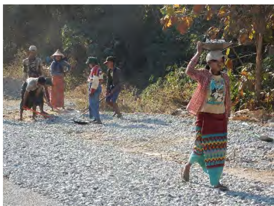
人力による碎石の小運搬
