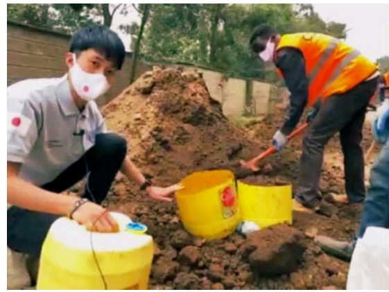
Fig.6 土のう工法紹介
