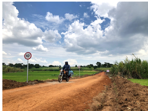
Fig.2 施工後の道路状況
