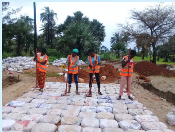
土のうを締め固め、道路の基礎を整備している女性たち(写真:道普請人)
