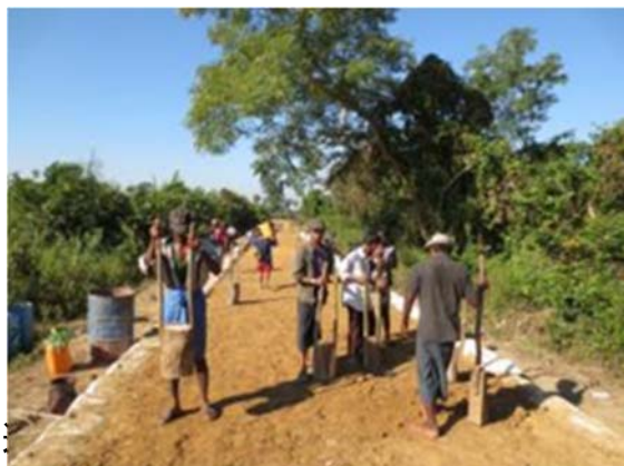
道路盛土、土のう（ソイルセメント中詰）の擁壁設置、人力による裏込めと締固め（ミャンマー）
