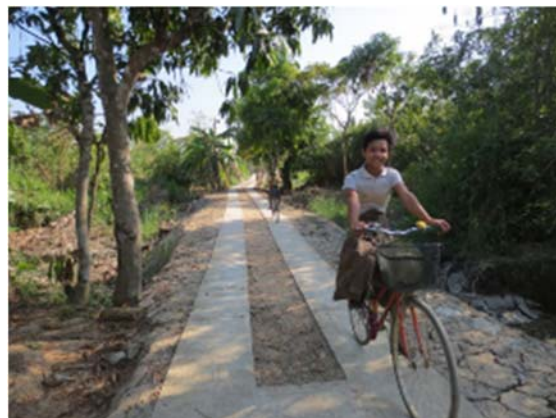
泥田状態の路面がコンクリート舗装により、自転車やバイクによる走行が可能
