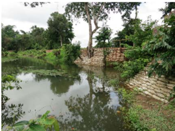
道路盛土でかさ上げし、雨季でも通行可能
