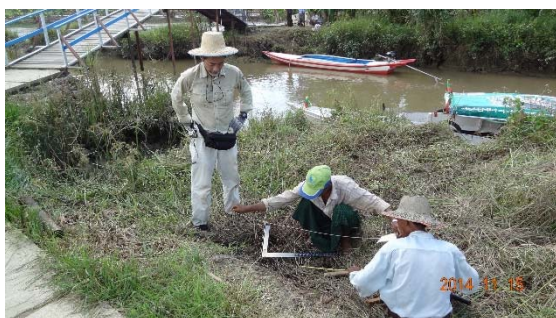
橋台位置出し （ミャンマー）
