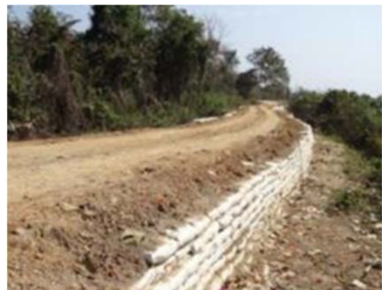
道路盛土、土のう（ソイルセメント中詰）の擁壁設置、人力による裏込めと締固め（ミャンマー）
