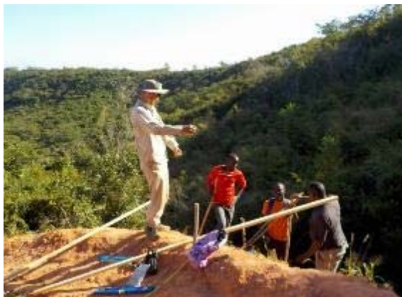
現地スタッフへ指示しながら丁張設置 （タンザニア）
