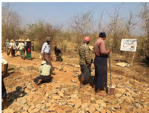
写真 13 村人の手によって道路補修が行われてれている様子
