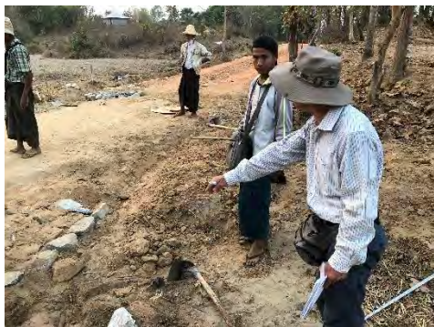
写真1 専門家と現地エンジニアによる現場での施工法確認の様子
