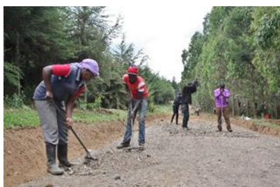
写真 7 表層を均して締め固め
