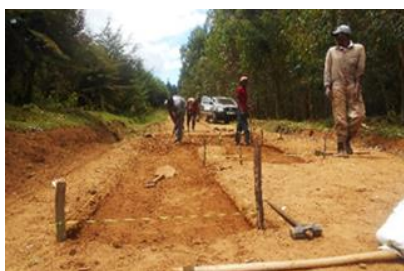
写真 2 水系を張り掘削
