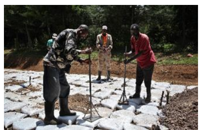
写真 5 土のうの締め固め
