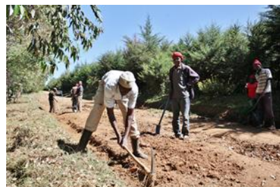
写真 3 排水路の掘削
