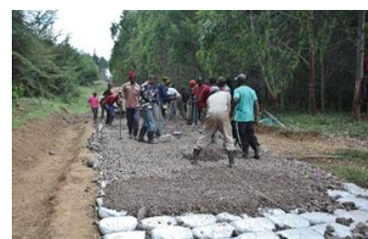
写真 6 土のうに土を被せ保護
