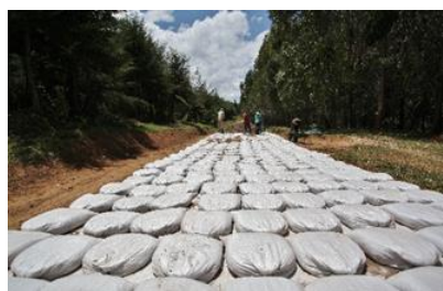
写真 4 土のうの配置
