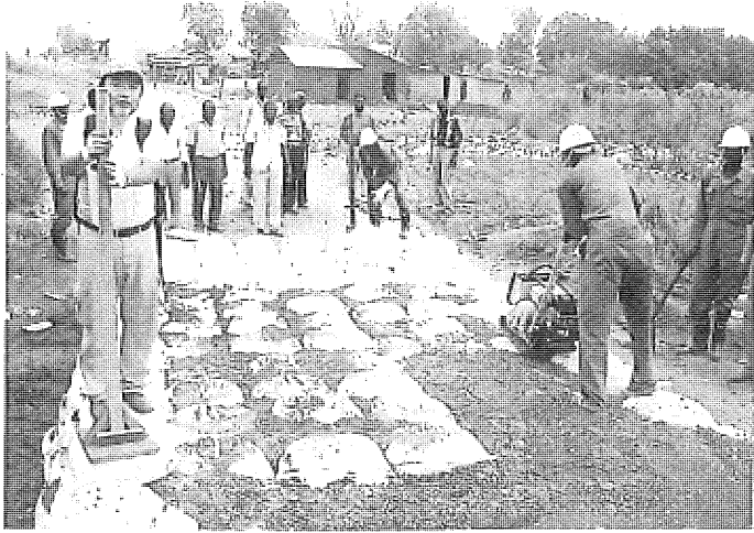
2012年12月、南スーダンの首都ジュバで土のうによる道路補修を手伝う筆者
