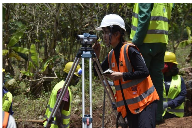
写真4 測量している様子
