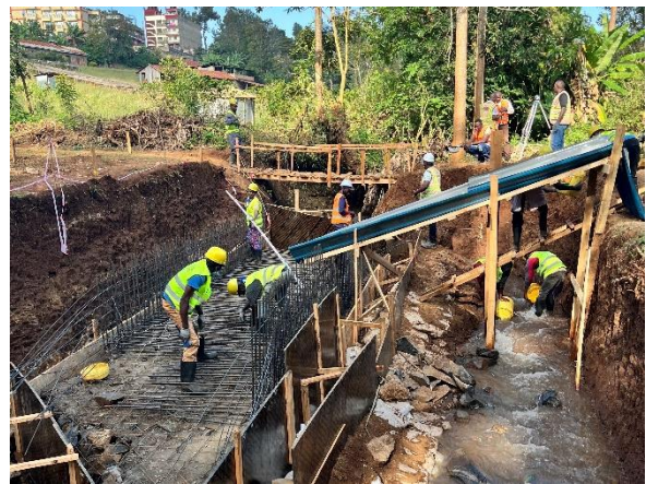
写真7 コンクリートを流し込む様子
