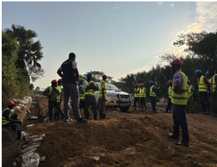
Photo4 道路作業の指示を出している様子
