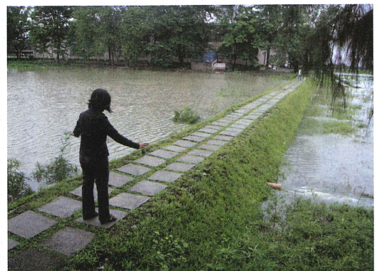
写真5 雨季でも立派に使える土のうの歩道
