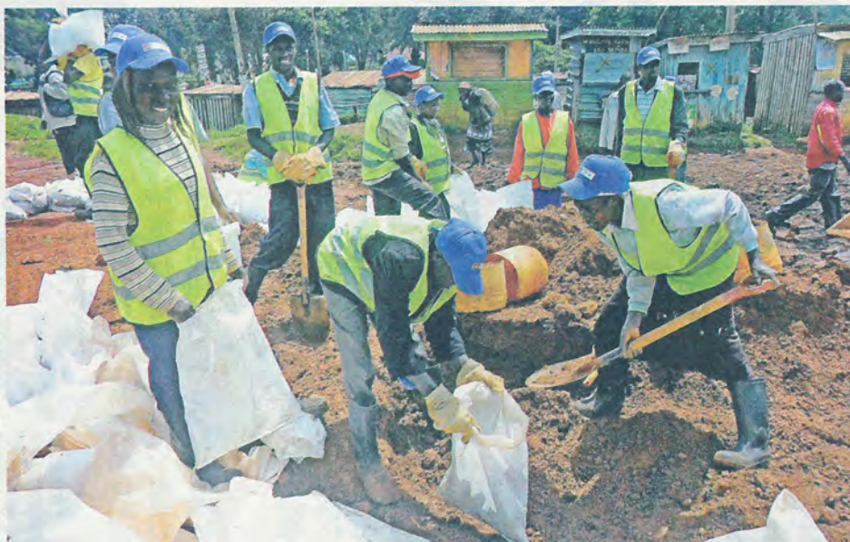
土のうを用いて農道を改良する住民(昨年夏、ケニア) NPO法人道普請人提供
