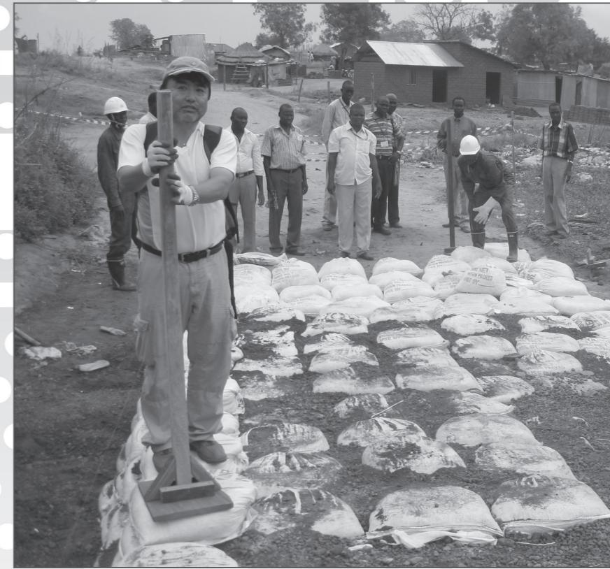
▲南スーダンでの道路補修の様子。土のうを押し固めて上から土をかけることで強度を確保する
