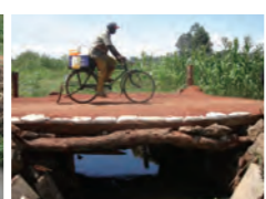
写真上左/ケニアにおける道直しの事例。この地域は東アフリカ特有の膨張性粘土の土質のため、雨が降ると深い轍(わだち)ができ、とくに車は通行不能になる。写真左/身近な材料で楯をこしらえ、土嚢を叩く。重労働だが、みんなで楽しく汗を流している。写真上右/悪路があったという間に丈夫で平坦な道に。雨が溜まらないよう、道路端に排水溝を造った。
