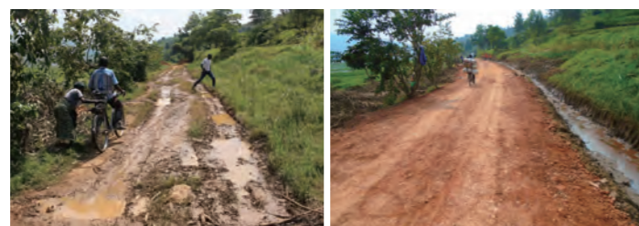
写真上左/ケニアにおける道直しの事例。この地域は東アフリカ特有の膨張性粘土の土質のため、雨が降ると深い轍(わだち)ができ、とくに車は通行不能になる。写真左/身近な材料で楯をこしらえ、土嚢を叩く。重労働だが、みんなで楽しく汗を流している。写真上右/悪路があったという間に丈夫で平坦な道に。雨が溜まらないよう、道路端に排水溝を造った。
