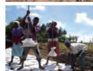
写真上左/ケニアにおける道直しの事例。この地域は東アフリカ特有の膨張性粘土の土質のため、雨が降ると深い轍(わだち)ができ、とくに車は通行不能になる。写真左/身近な材料で楯をこしらえ、土嚢を叩く。重労働だが、みんなで楽しく汗を流している。写真上右/悪路があったという間に丈夫で平坦な道に。雨が溜まらないよう、道路端に排水溝を造った。
